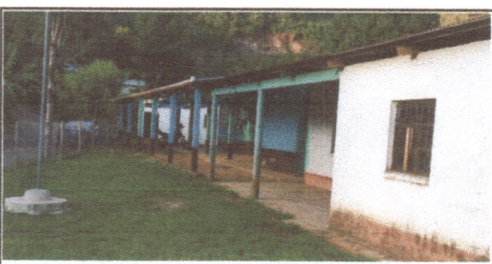
Foto 6: Sustitución de canal a canal de metal con bajada de agua pluvial. Colocación de porton en entrada principal.
