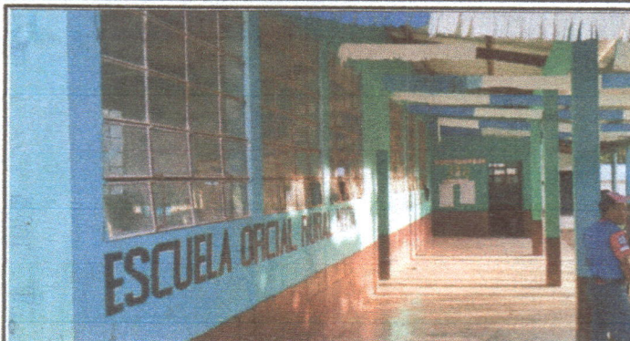
Foto 2: Reforzamiento de ventanas con balcon de 2*2m en todo el corredor de la escuela, áreas de dirección y bodega, para resguardo de aparatos tecnológico de FUNSEPA(tablet)
