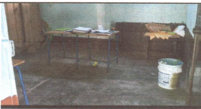
Foto 5: Mejoramiento de piso de concreto a piso cerámico de 33*33 en área de bodega y cocina
