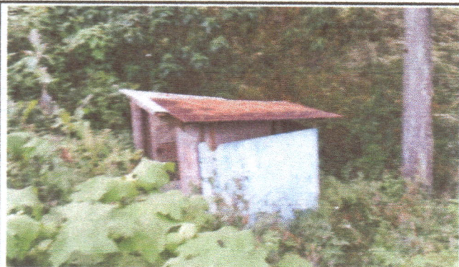
Foto 1: Mejoramiento de paredes de los baños, columna, cambio de letrina a inodoro, cambio de techo a lamina troquelada, costanera, tubería de drenaje a fosa séptica. Sustitución de 3 puertas a metal.
